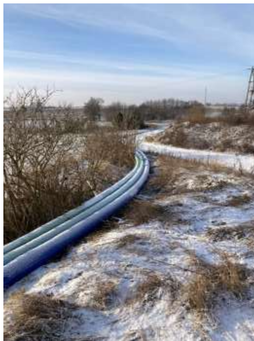
Prace remontowe kolektora ściekowego
