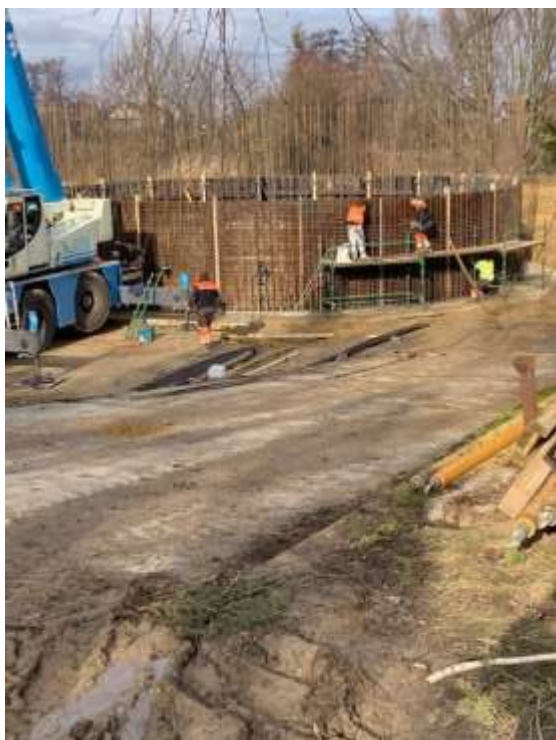
Modernizacja oczyszczalni ścieków
