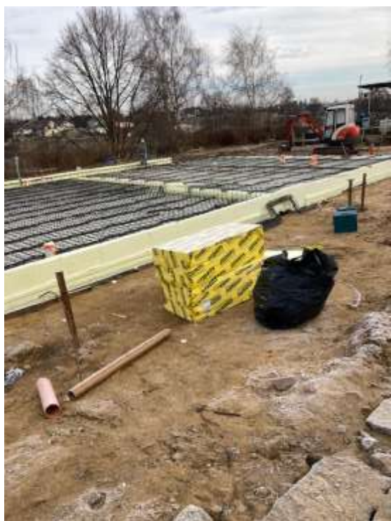
Modernizacja oczyszczalni ścieków
