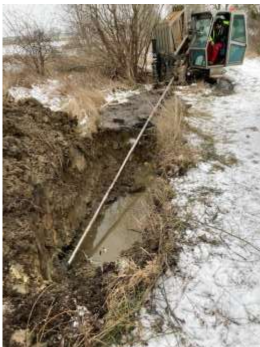
Prace remontowe kolektora ściekowego
