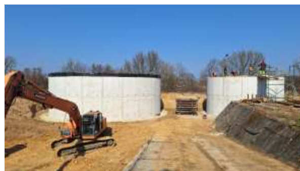
Rozbudowa i modernizacja oczyszczalni ścieków w Kiełczyńku
