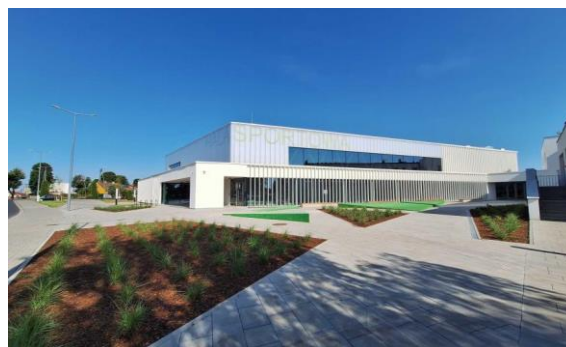
Hala widowiskowo-sportowa w Książu Wlkp. z zewnątrz
