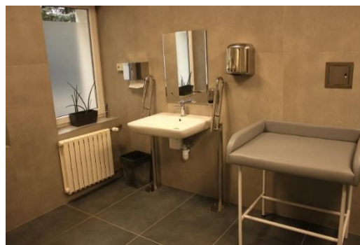
Zmodernizowana i dostosowana do osób ze szczególnymi potrzebami toaleta na piętrze Urzędu
