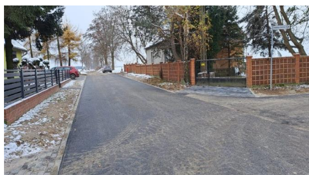
Przebudowa drogi wewnętrznej w Chwałkowie Kościelnym Całkowita wartość inwestycji: 159 000,00 zł
