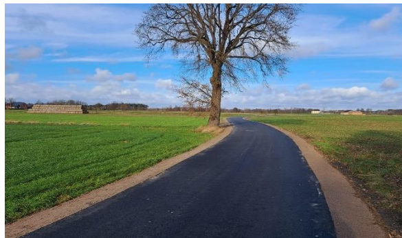
Budowa dróg dojazdowych do gruntów rolnych: Przebudowa drogi w Zakrzewicach Całkowita wartość inwestycji: 594 938,92 zł
