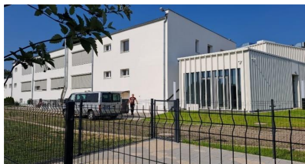
Modernizacja elewacji budynku Przedszkola I opłotowania w Książu Wlkp. Całkowita wartość inwestycji: 87 341,41 zł
