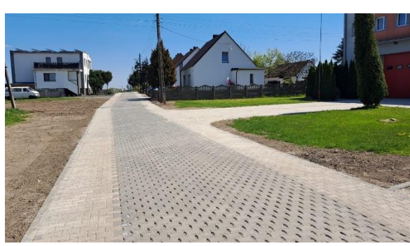
Przebudowa drogi przy OSP Chwałkovo Kościelne Całkowita wartość inwestycji: 136 849,80zł
