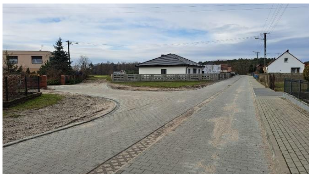
Przebudowa drogi gminnej nr 603 005P w Zaborowie Całkowita wartość inwestycji: 641 894,06 zł
