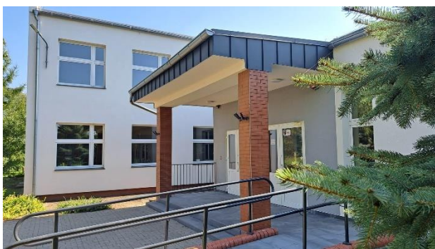
Modernizacja elewacji budynku Szkoły Podstawowej w Mchach Całkowita wartość inwestycji: 589 567,37 zł
