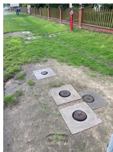
Węzeł zasów nowej sieci wodociągowej
