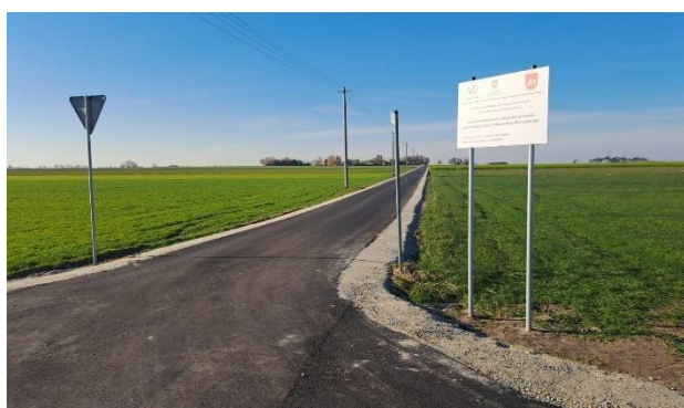
Przebudowa dróg dojazdowych do gruntów rolnych: Przebudowa drogi w Radoszkowie odc. 1 i odc. 2 Całkowita wartość inwestycji: 747 227,00 zł
