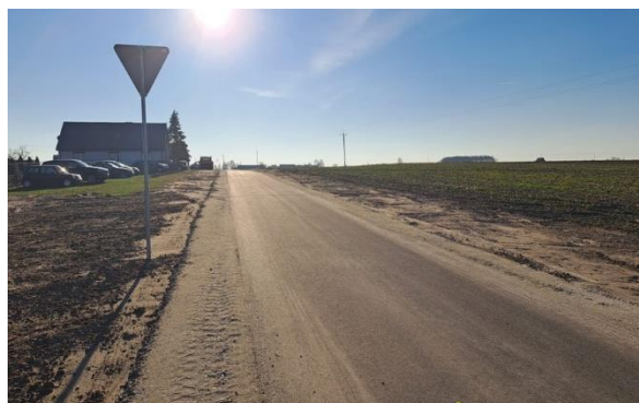
Przebudowa dróg dojazdowych do gruntów rolnych: Przebudowa drogi w Radoszkowie odc. 3 Całkowita wartość inwestycji: 242 140,00 zł
